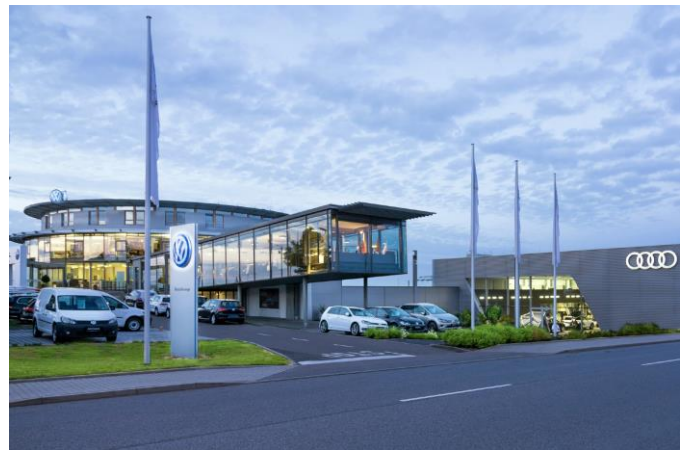
Standort Kesselsdorfer Straße, Dresden
